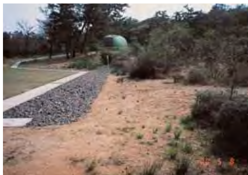
写真1 排水工事施工直後の状態. 2000年5月8日
