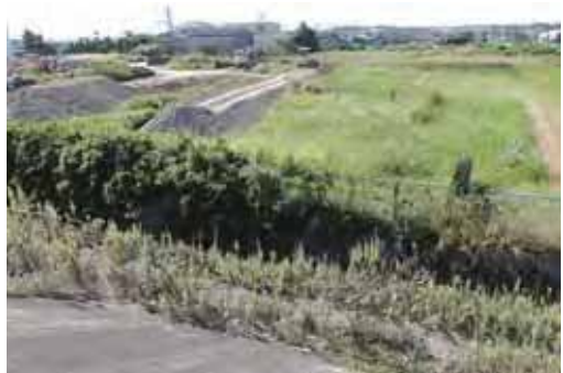
写真1 埋め立てが生息地の際まで進む津市河芸町の海岸堤防下。休耕田の水路際にウマスゲの生息地(2009年9月20日)
