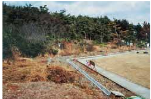
写真4 排水対策工事改良版実施中(2001年1月23日)
