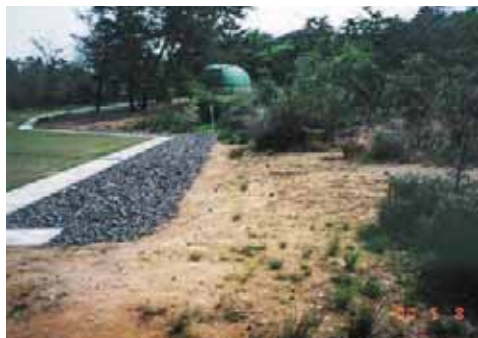
写真2 排水対策工事直後の湿地（2000年5月8日）
