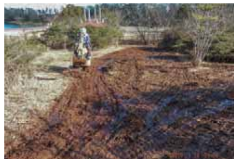
写真9 重機をつかったの除草作業(2016年1月23日)
