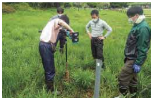
井戸を掘って手前の管を埋め込む
