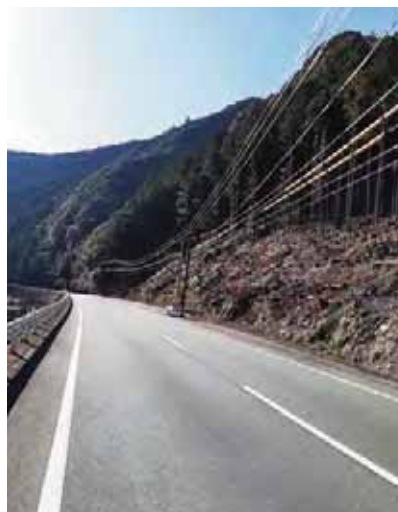
写真1. 工事現場（大台町滝谷，2020年12月27日）
