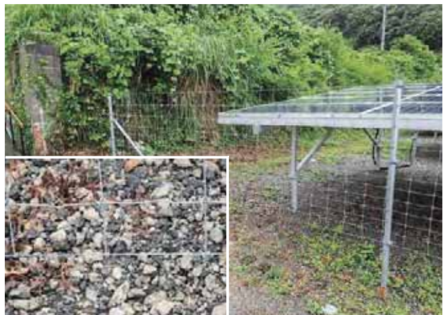
写真3 太陽光発電施設（左後方の草や壁で多数確認）とアスファルト舗装の細片が混じる埋め戻し材
