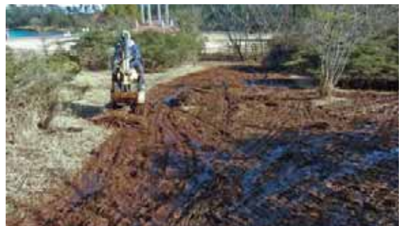
写真3 重機で表層をはがしていく作業
