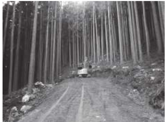
写真3 作業道開設状況
