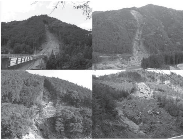
図-2 2004年の宮川豪雨災害時に発生した表層崩壊
