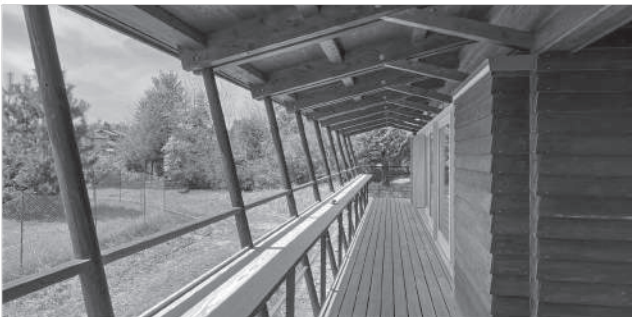
大教室南面のデッキ
