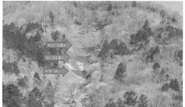
治山施設（土留工）の状況
