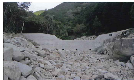
平成30年度復旧治山事業（補正） 第19号工事（弓山）
