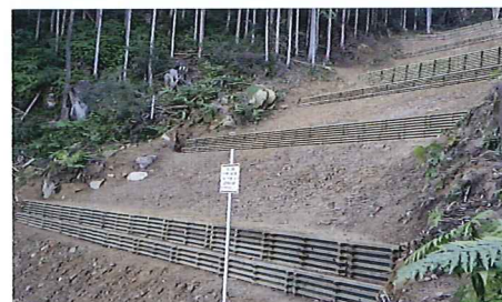
平成31年度自然災害防止事業（県単） 第尾－1号工事（太地）
