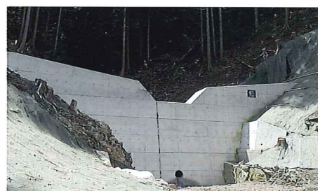
民有林治山工事コンクール H29自然災害防止事業第尾-1号工事
