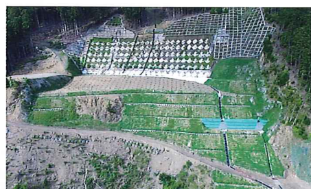
民有林治山工事コンクール H28復旧治山事業 第12号工事
