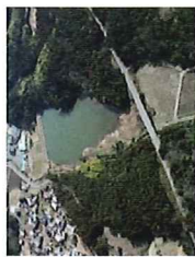
下流に家屋等のあるため池
