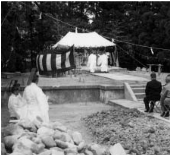
昭和31年、三重県護国神社の儀式殿立柱祭
