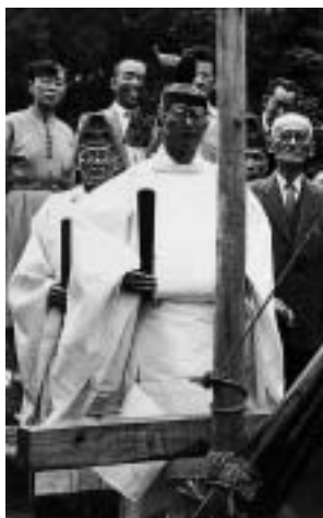
立柱祭を奉仕する林宮司
